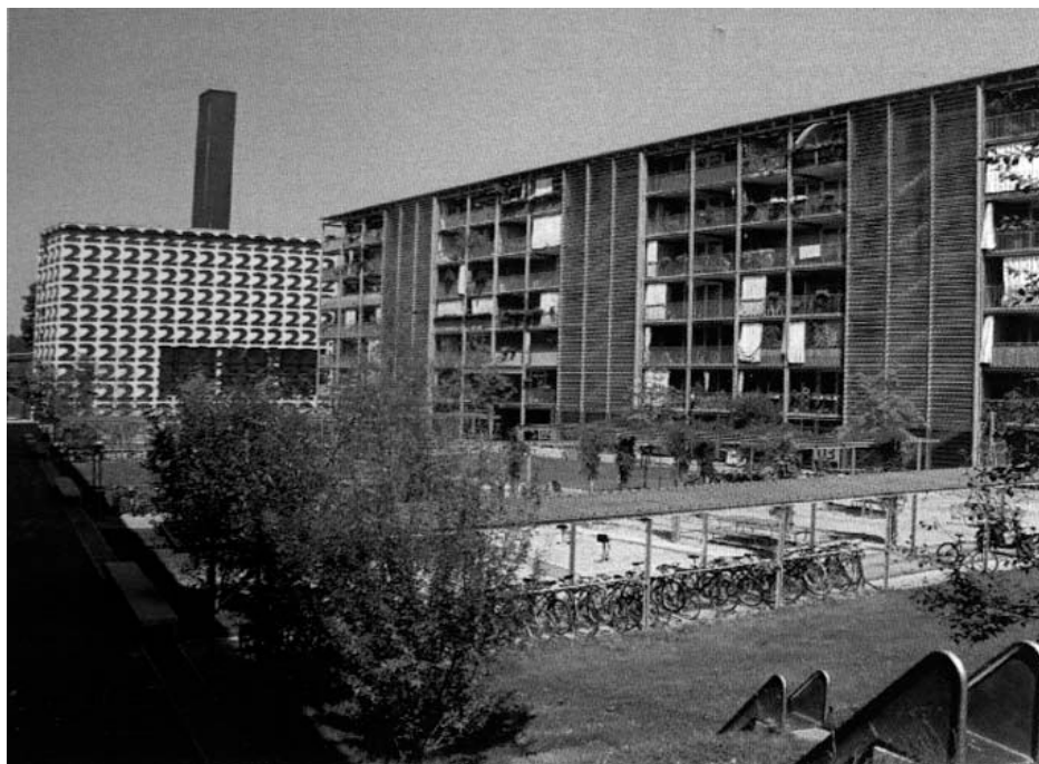
Abbildung 8: Regina-Kägi-Hof: Zeile 1 und Innenhof. Heizkraftwerk im Hintergrund
