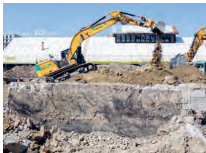
16. Februar: Baustart der vierten Kraftwerk1-Siedlung im künftigen Koch-Quartier.
