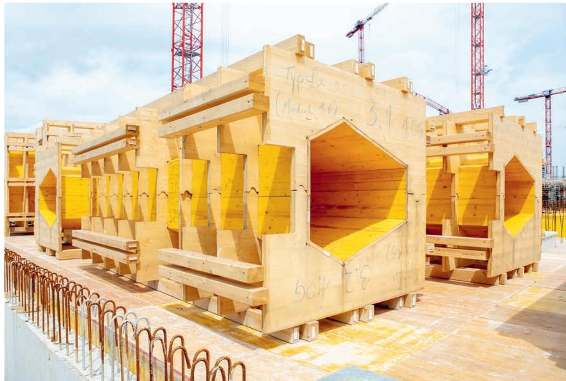
Eindrücke von der Baustelle Koch. Vom Betonieren der Bodenplatte über das Fassaden-Mockup bis hin zu den Schalungen für die Diamant-Betonstützen.
