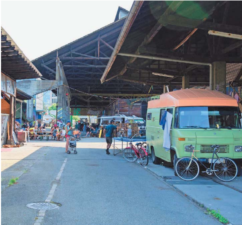
Die denkmalgeschützte Kohlenlagerhalle auf dem Koch-Areal wird in den geplanten Quartierpark integriert. Foto: Reto Oeschger
