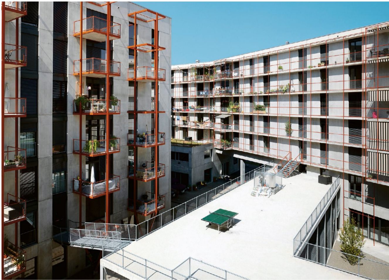
Rau, aber nicht roh: Aussenansicht der Siedlung Zwicky Süd. Foto: Andrea Helbling Arazebra
